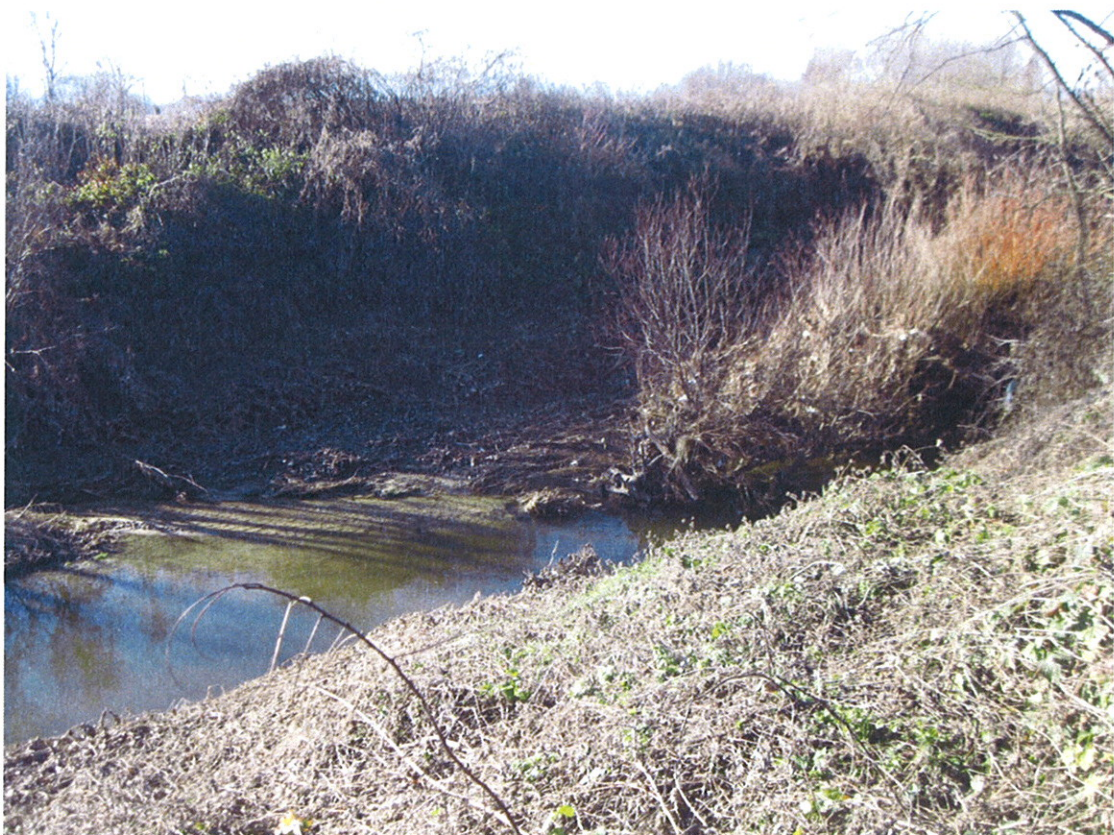
Foto 6 comune di Poirino, zona in erosione da ripristinare con gabbioni
