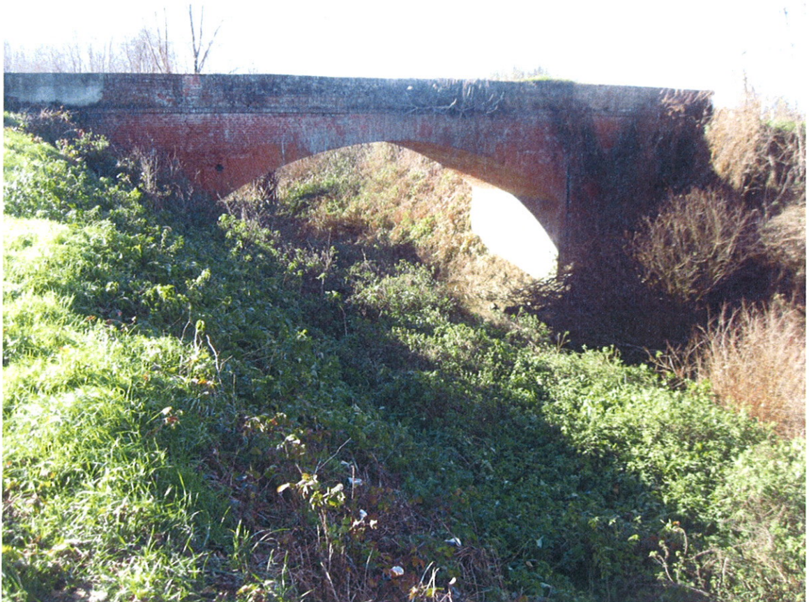
Foto 4 comune di Poirino, zona con deposito da movimentare e decespugliare
