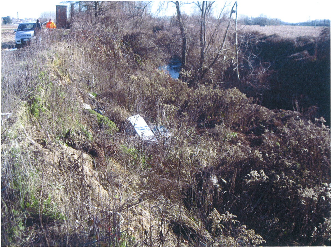
Foto 7 comune di Poirino, zona in erosione da ripristinare con gabbioni
