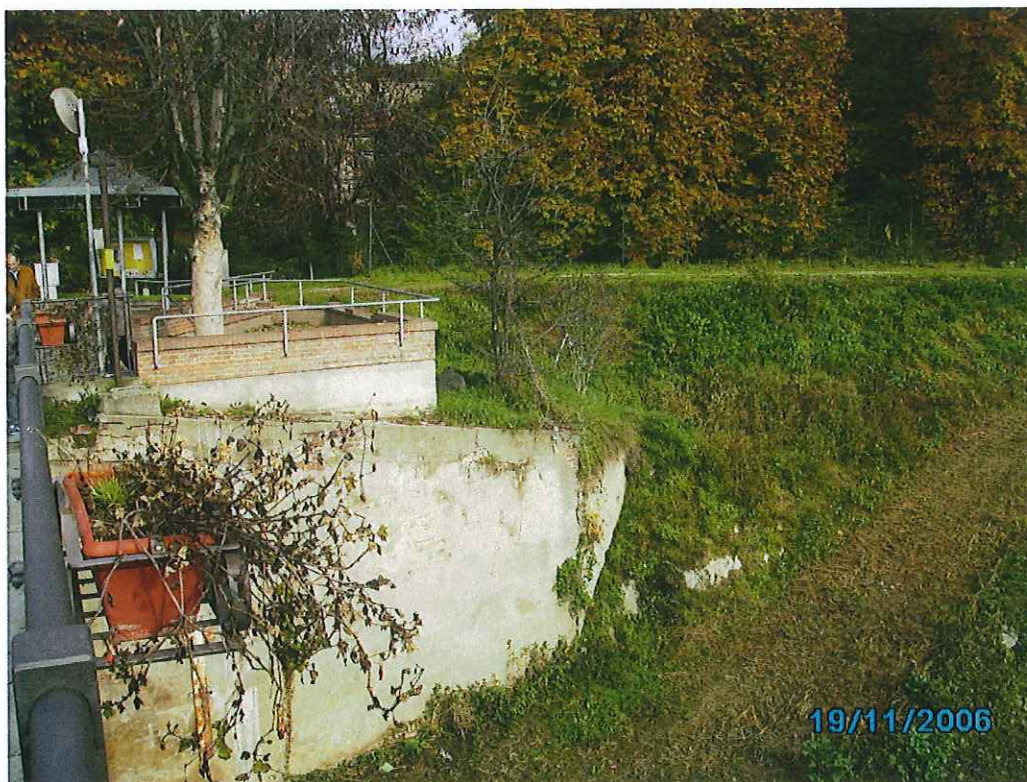
foto. 1: vista piazza dal ponte - ante I lotto
