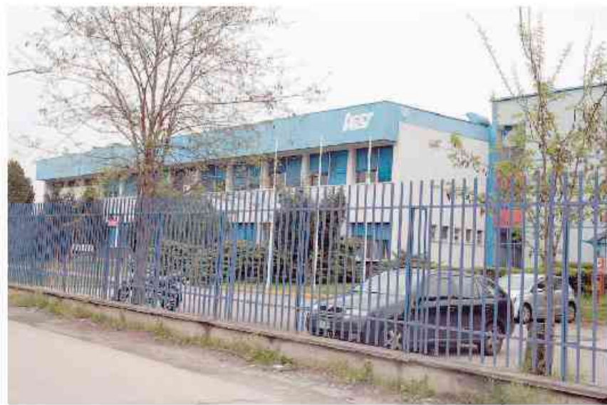
Fabbrica In una immagine di archivio lo stabilimento Ages di strada Cascina Cauda
